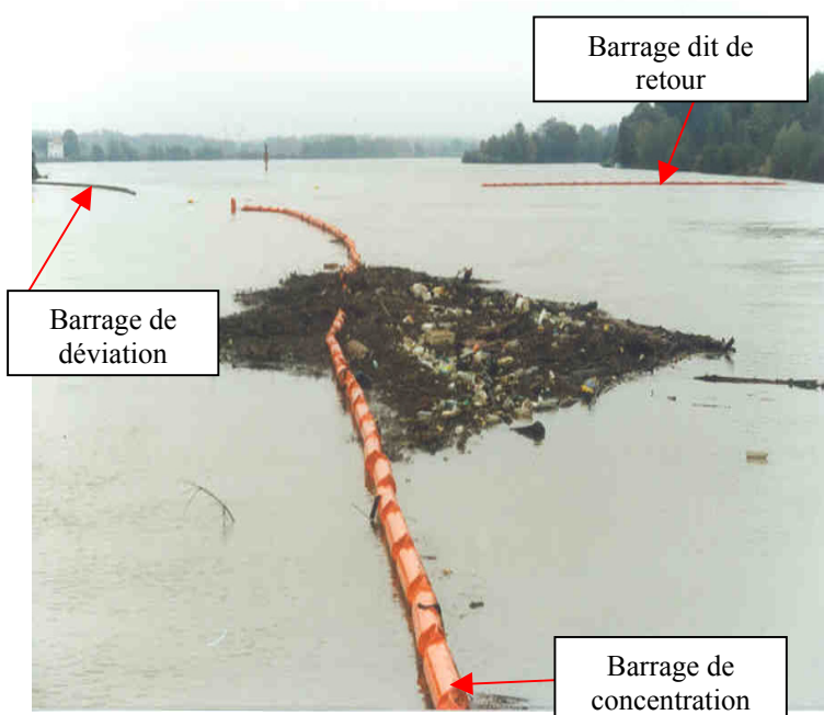
Barrages flottants permettant la collecte de macro déchets
