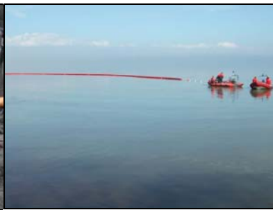
Déploiement du barrage (source : Cedre)
