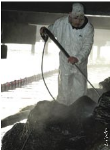
Nettoyage d'un enrochement sous un appontement sur pilotis. Port à fort marnage.
