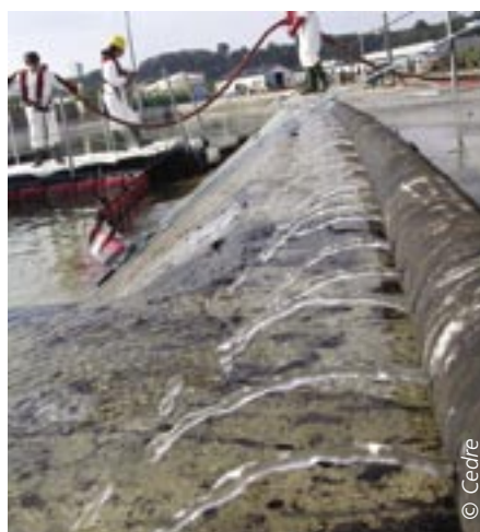
Tapis d'eau pour protection d'un quai ou d'une cale.
