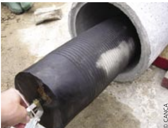
Introduction d'un obturateur gonflable dans une canalisation d'évacuation d'eaux usées.
