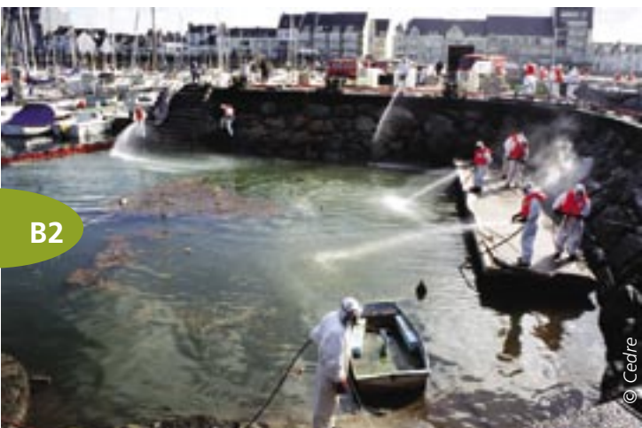
Nettoyage d'enrochements et d'un bassin portuaire à la suite d'une pollution par fuel lourd. Port de la Turballe (44).
