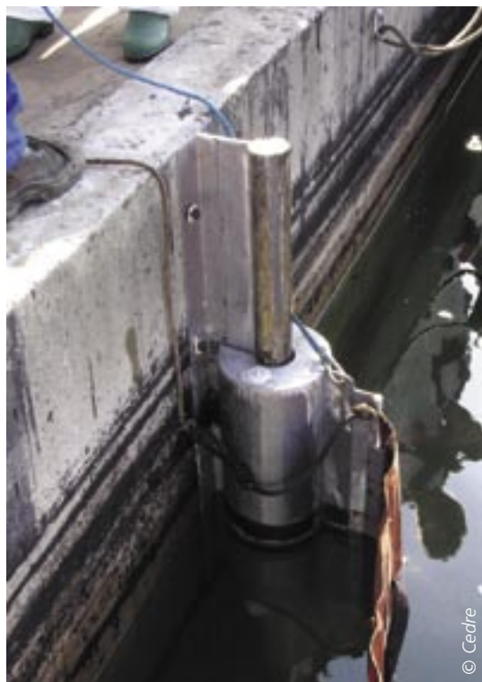
Ancrage de barrage, dispositifs compensateurs de marée du type câble lesté ou du type flotteur sur glissière.
