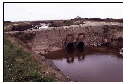
barrage en terre busé
