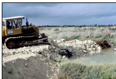
barrage en empièremment non busé
